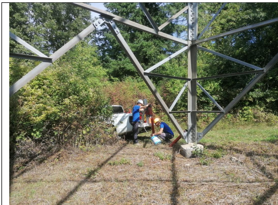
Esecuzione carotaggio P. 139
