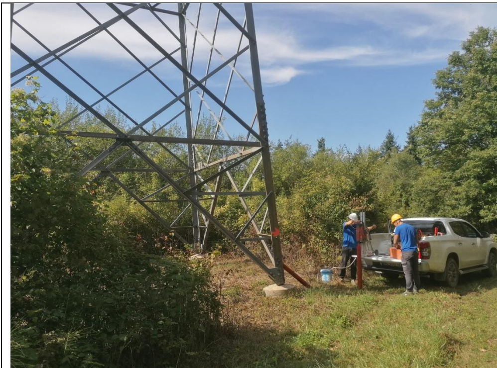
Esecuzione carotaggio P. 139
