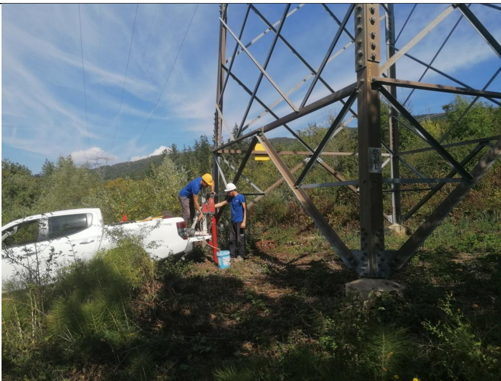
Esecuzione carotaggio P. 140
