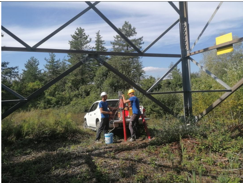
Esecuzione carotaggio P. 140
