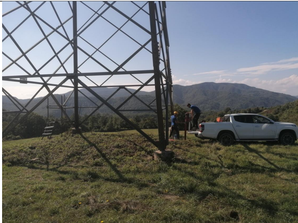
Esecuzione carotaggio P. 141
