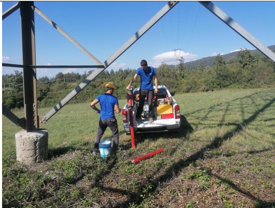
Esecuzione carotaggio P. 141
