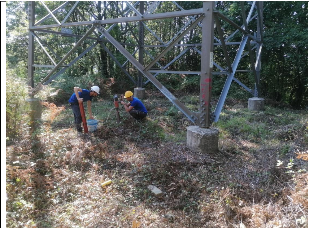
Esecuzione carotaggio P. 142
