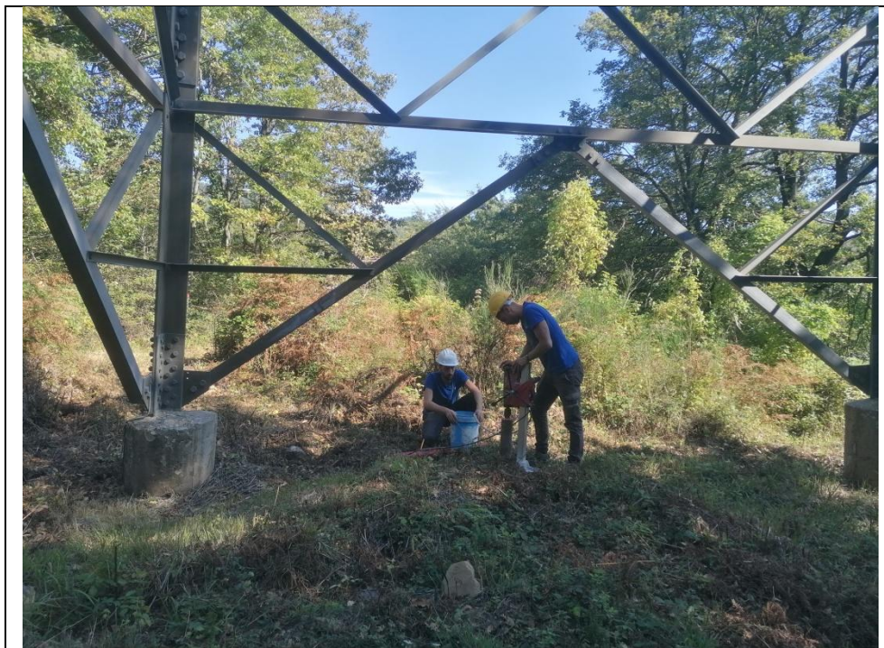
Esecuzione carotaggio P. 142
