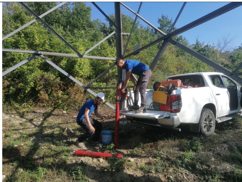
Esecuzione carotaggio P. 144
