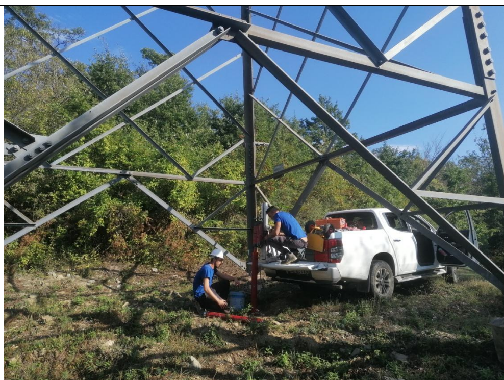
Esecuzione carotaggio P. 144
