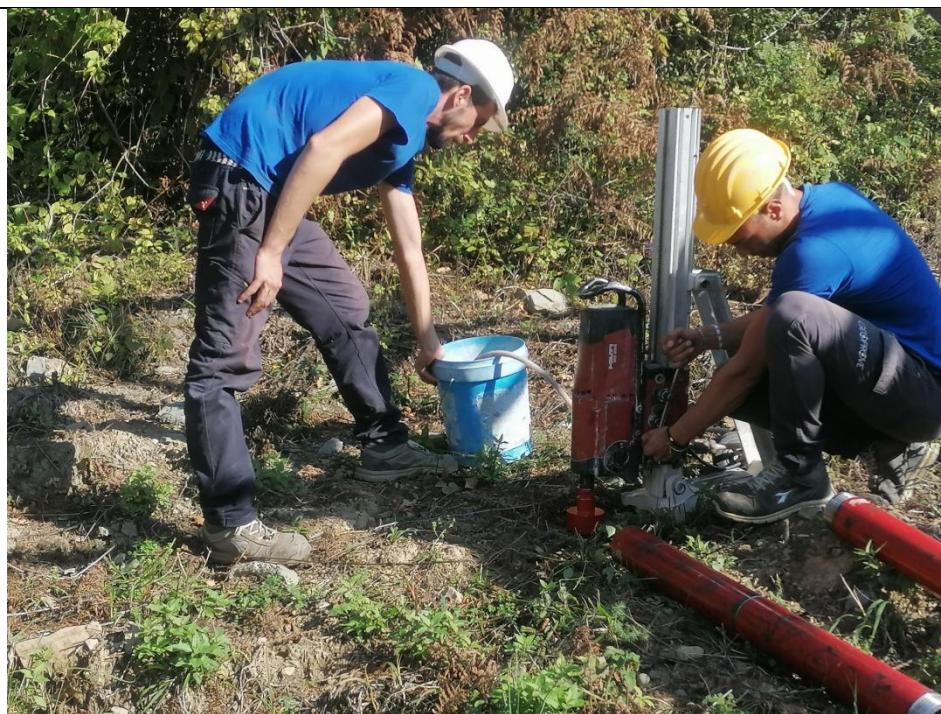
Esecuzione carotaggio P. 145
