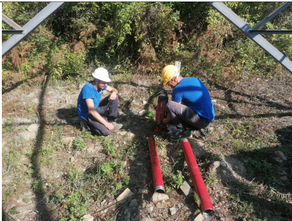
Esecuzione carotaggio P. 145
