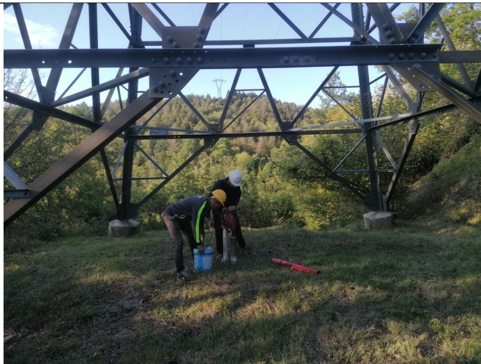
Esecuzione carotaggio P. 146
