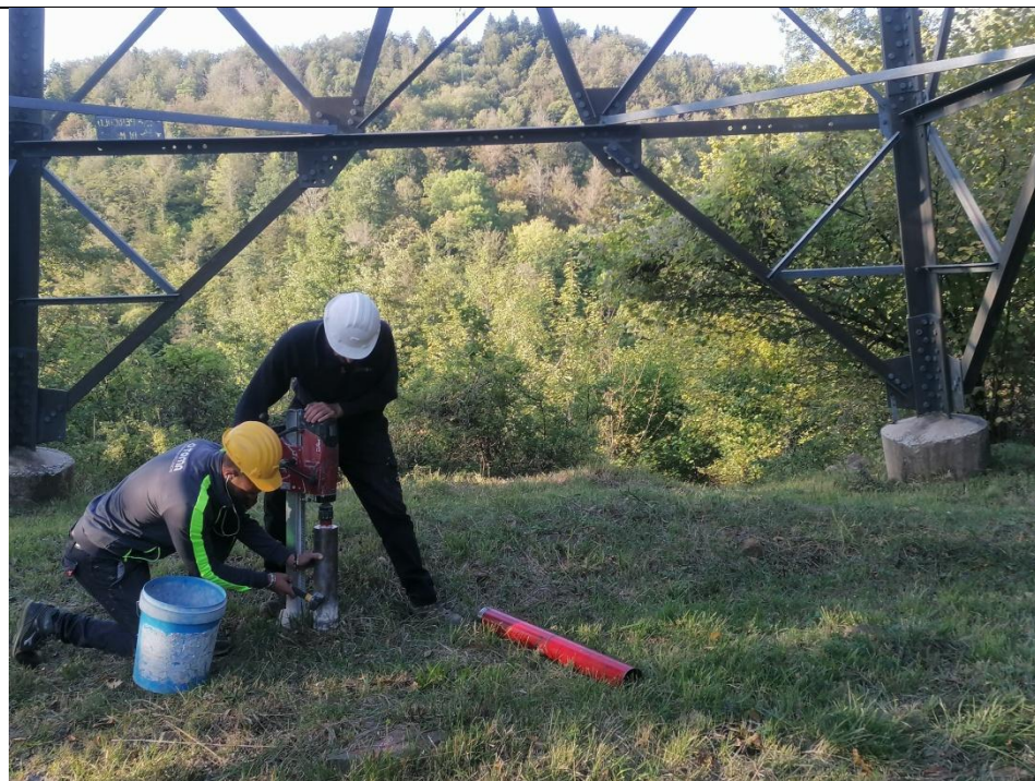
Esecuzione carotaggio P. 146
