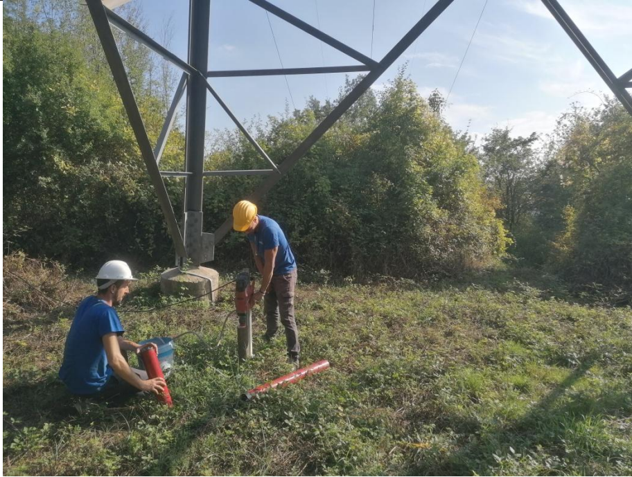
Esecuzione carotaggio P. 148
