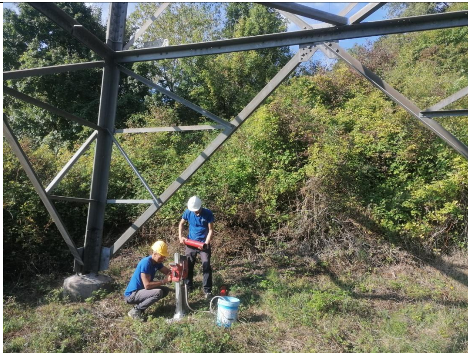
Esecuzione carotaggio P. 148
