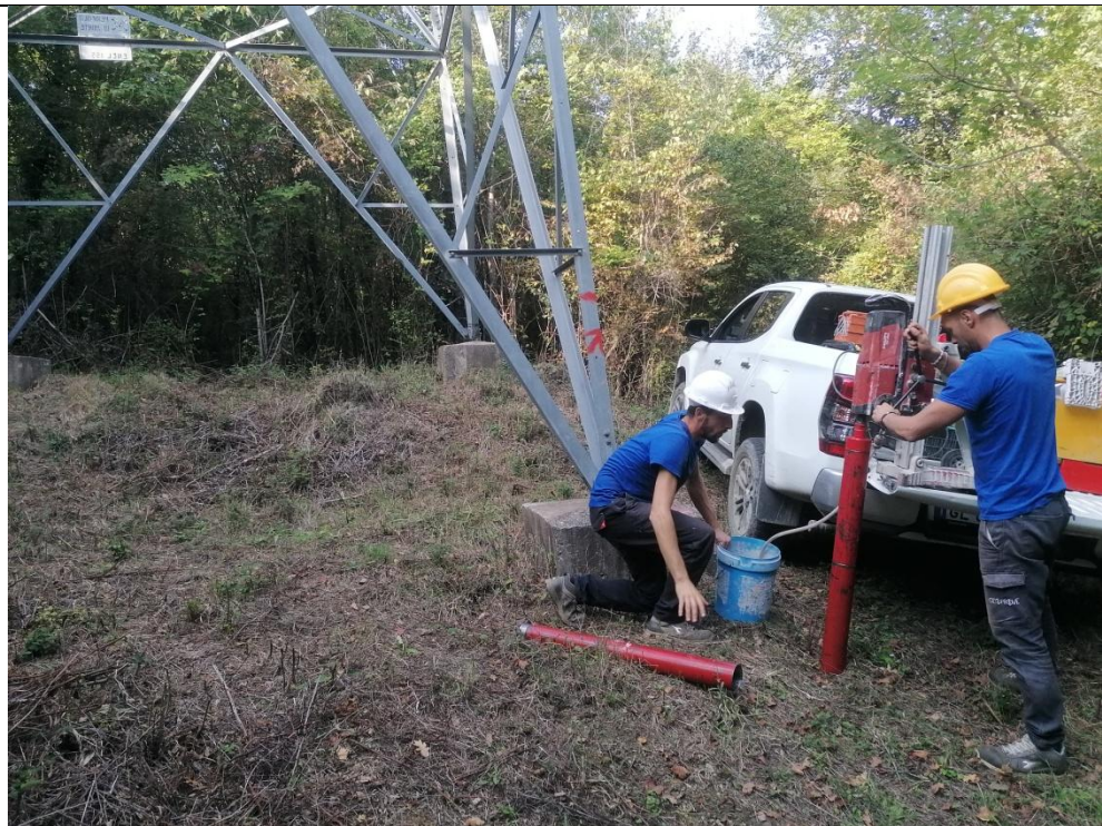
Esecuzione carotaggio P. 149
