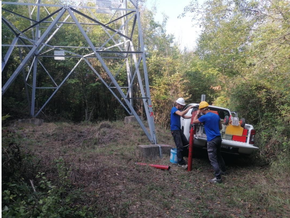
Esecuzione carotaggio P. 149
