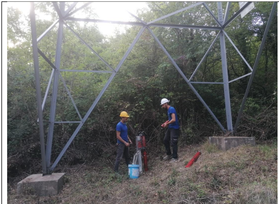
Esecuzione carotaggio P. 150
