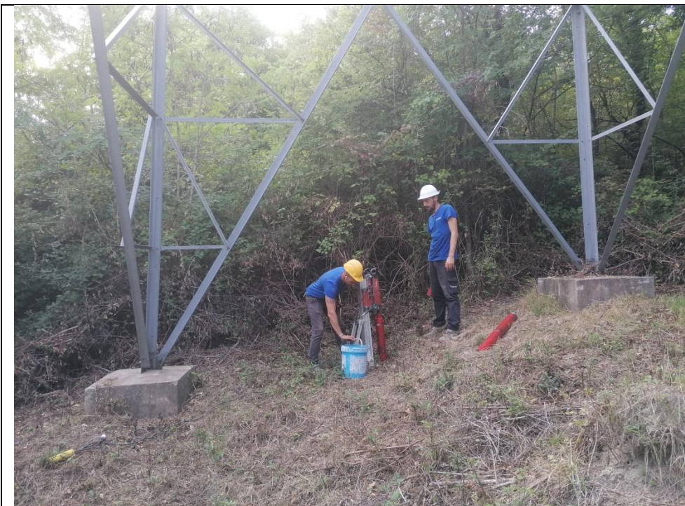
Esecuzione carotaggio P. 150
