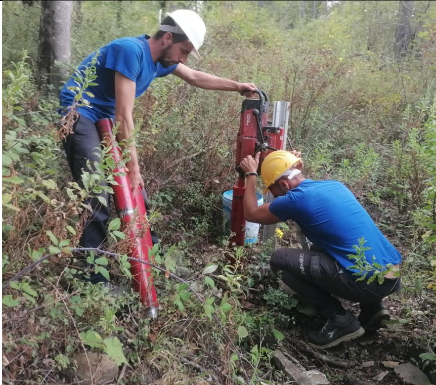
Esecuzione carotaggio P. 151
