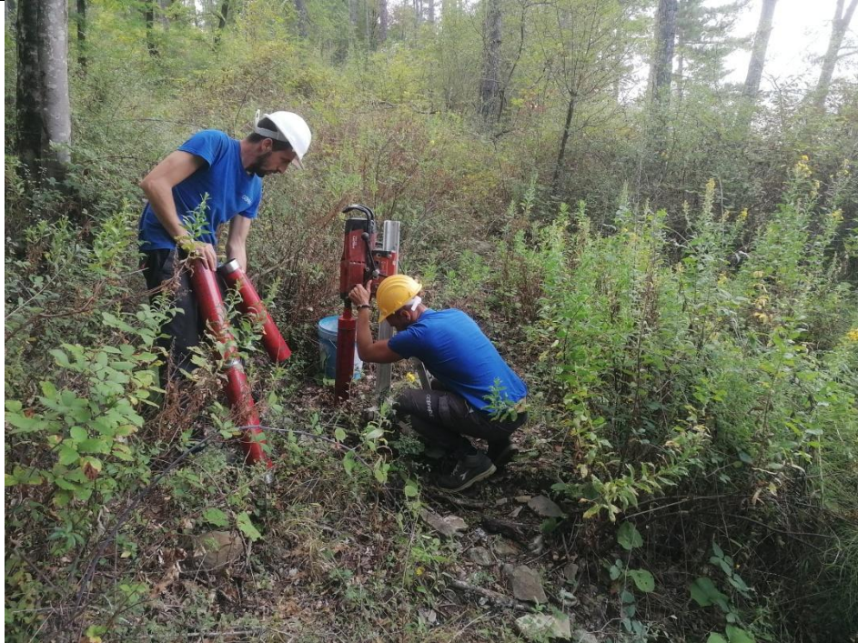
Esecuzione carotaggio P. 151incl
