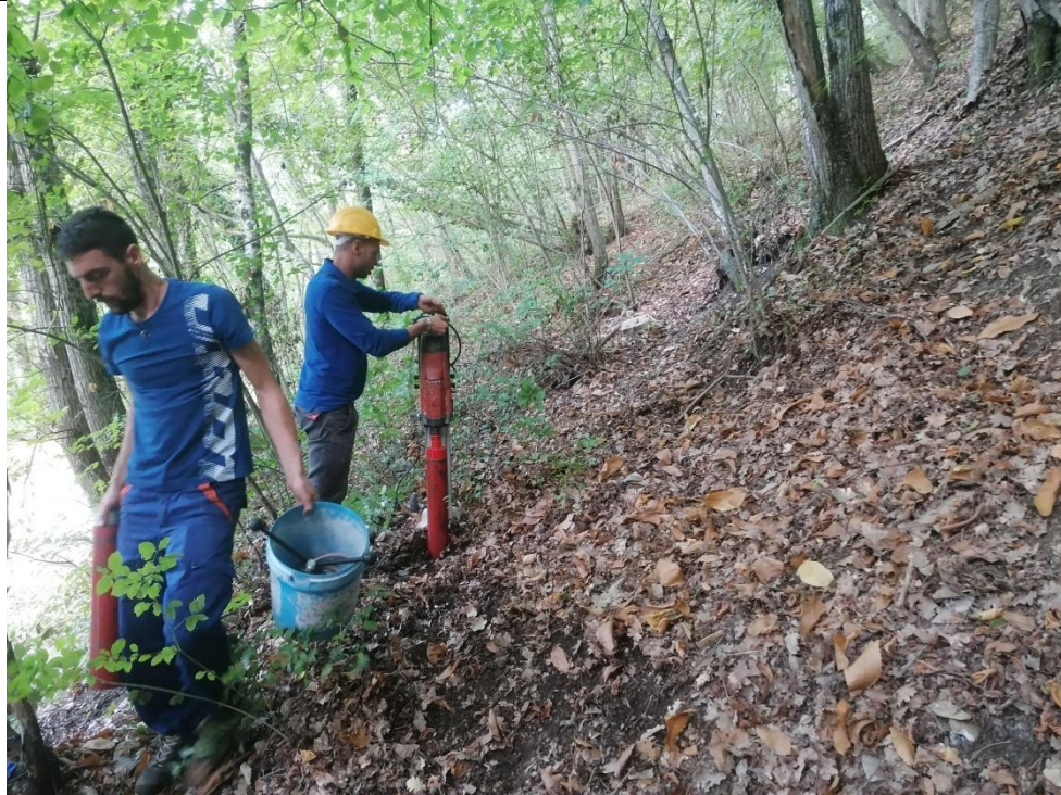
Esecuzione carotaggio P. 154
