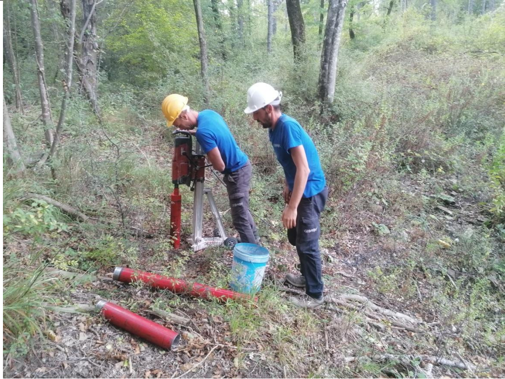
Esecuzione carotaggio P. 155
