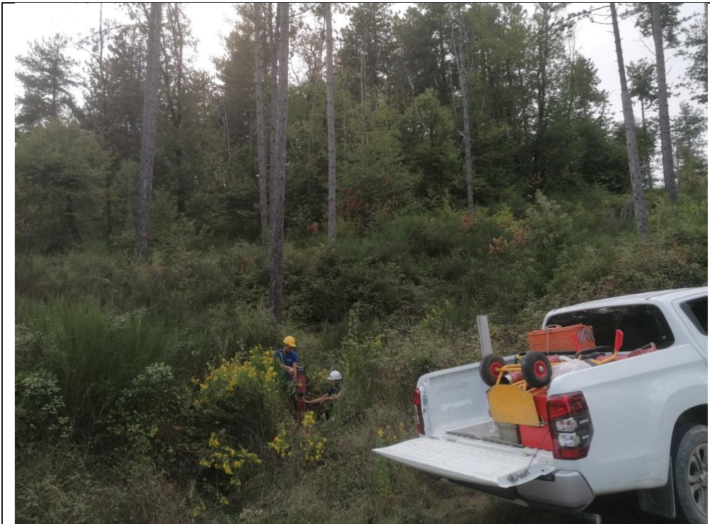
Esecuzione carotaggio P. 156
