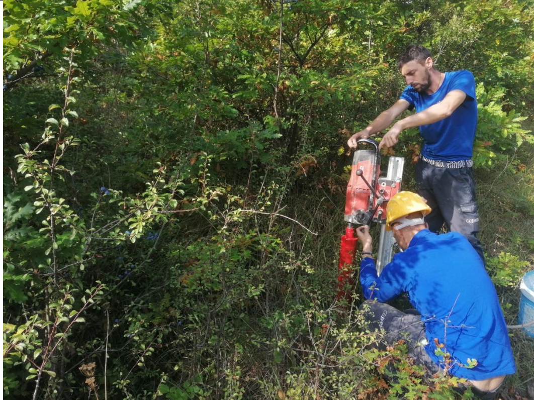
Esecuzione carotaggio P. 157
