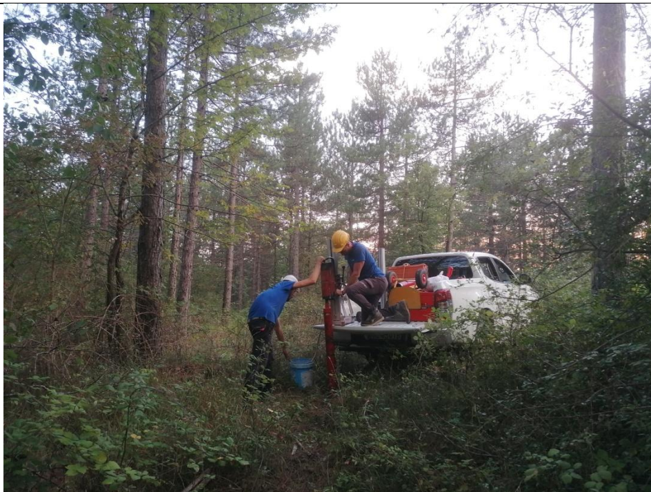
Esecuzione carotaggio P. 158
