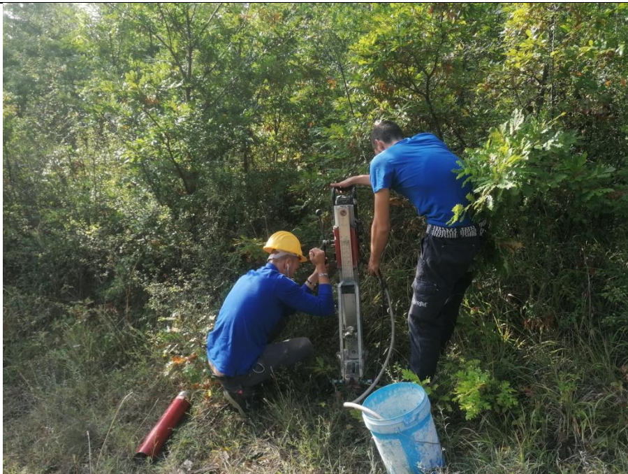
Esecuzione carotaggio P.15G
