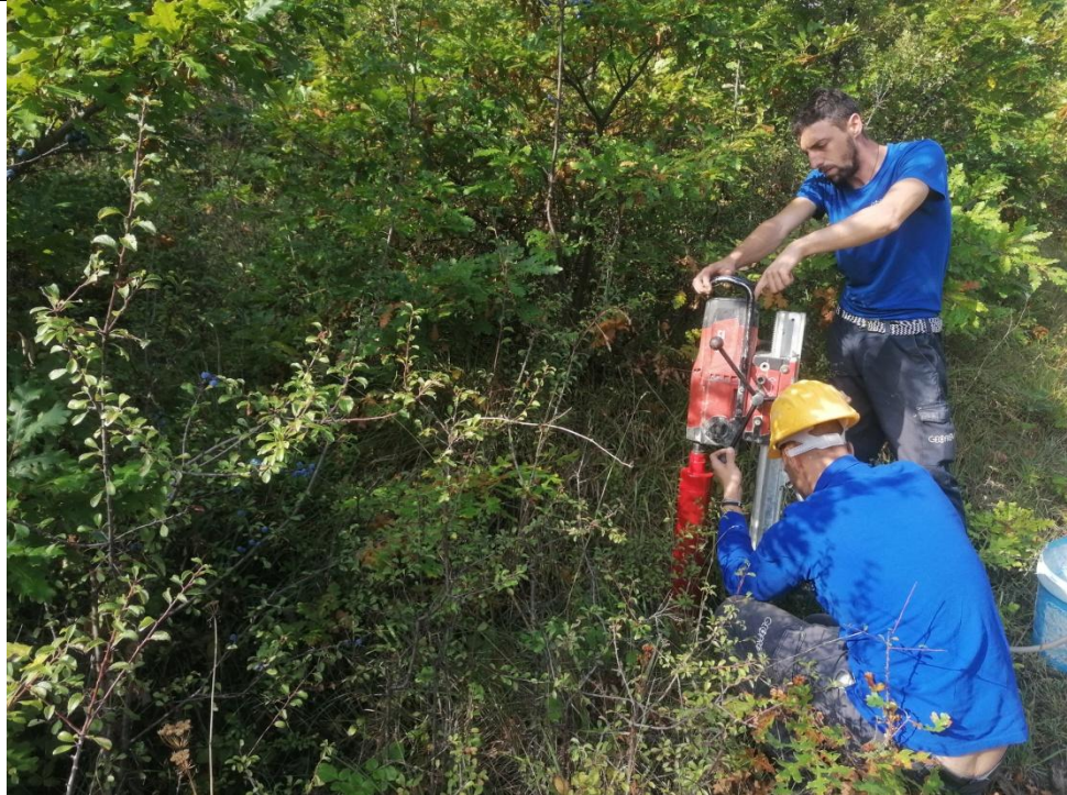
Esecuzione carotaggio P.15G
