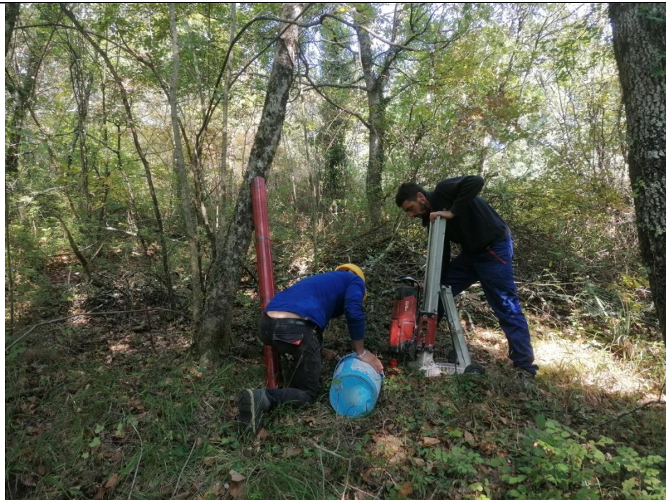
Esecuzione carotaggio P. 160
