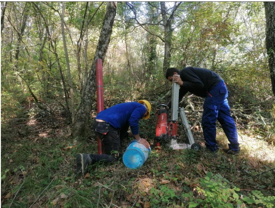
Esecuzione carotaggio P. 160
