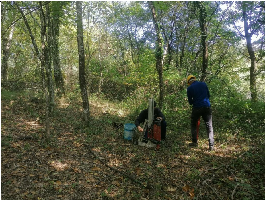
Esecuzione carotaggio P. 161
