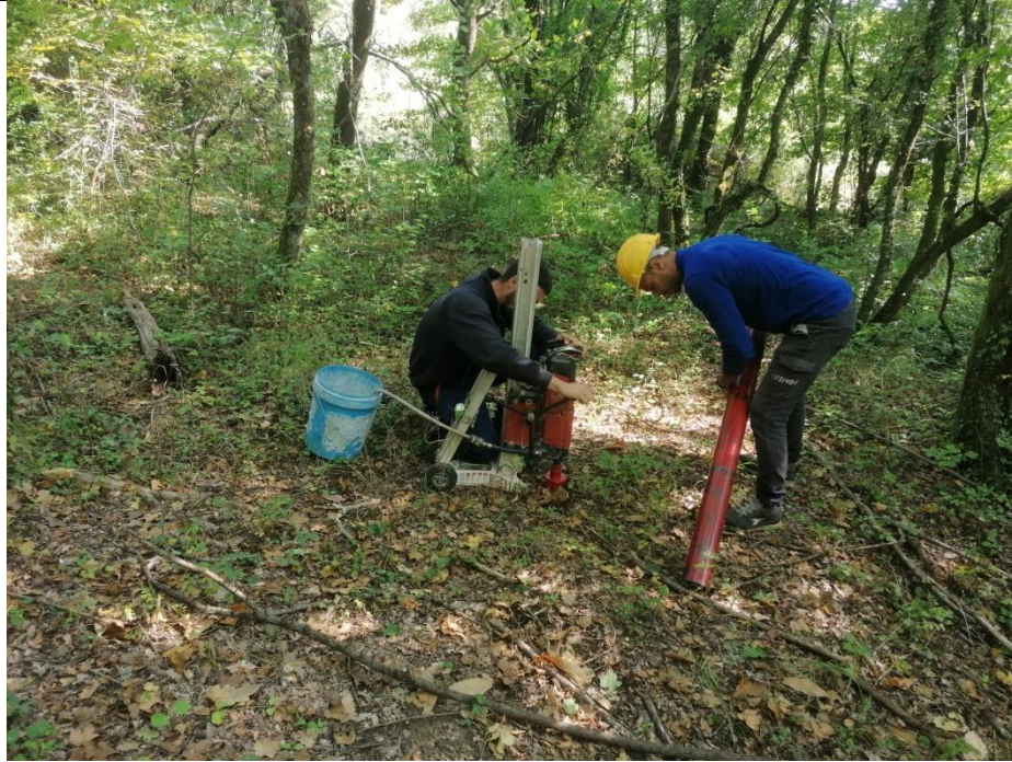
Esecuzione carotaggio P. 161
