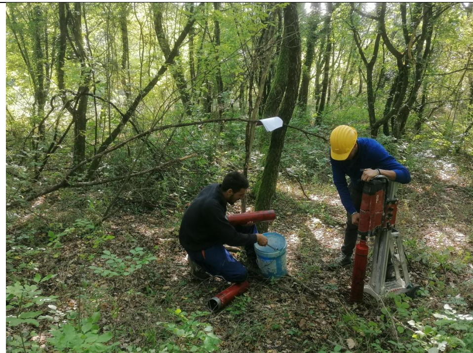
Esecuzione carotaggio P. 162
