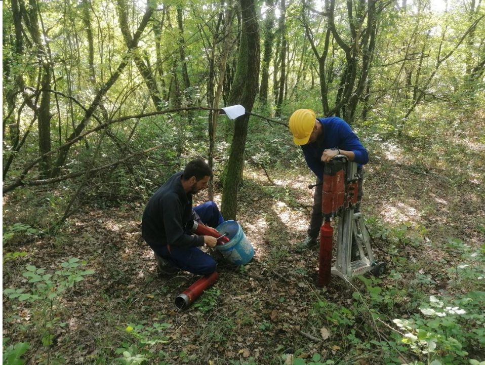
Esecuzione carotaggio P. 162
