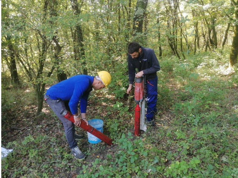
Esecuzione carotaggio P. 163
