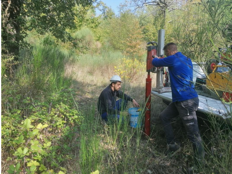
Esecuzione carotaggio P. 164
