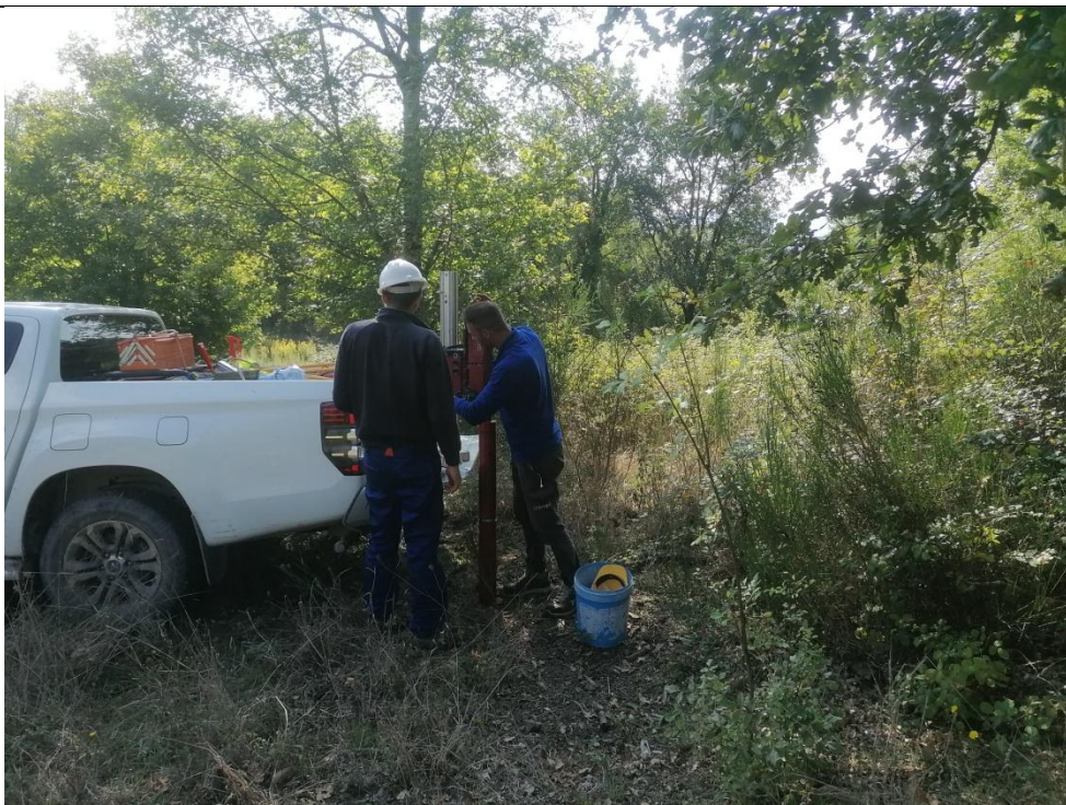
Esecuzione carotaggio P. 164
