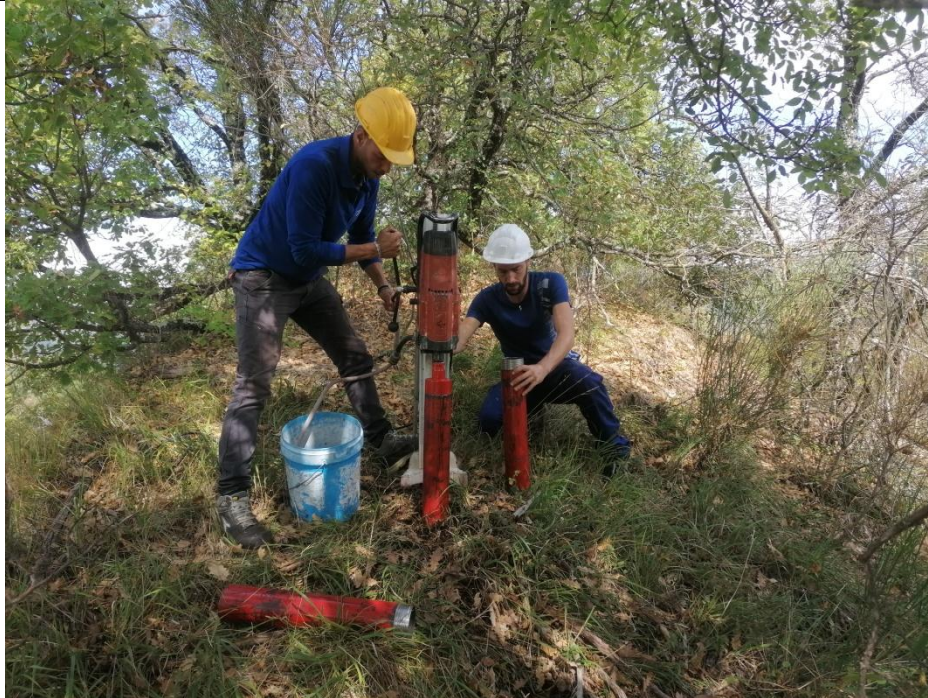
Esecuzione carotaggio P. 165
