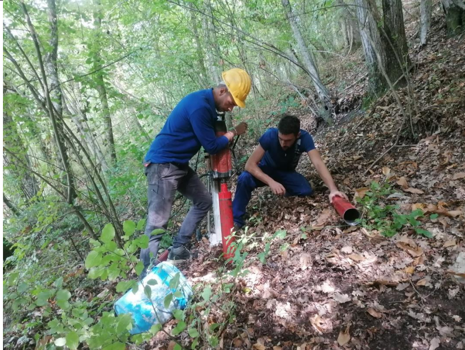
Esecuzione carotaggio P. 166
