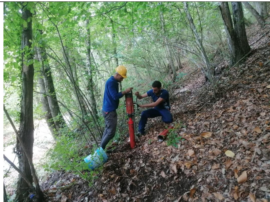
Esecuzione carotaggio P. 166
