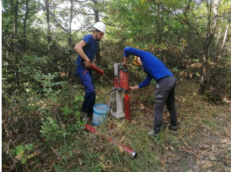
Esecuzione carotaggio P. 167
