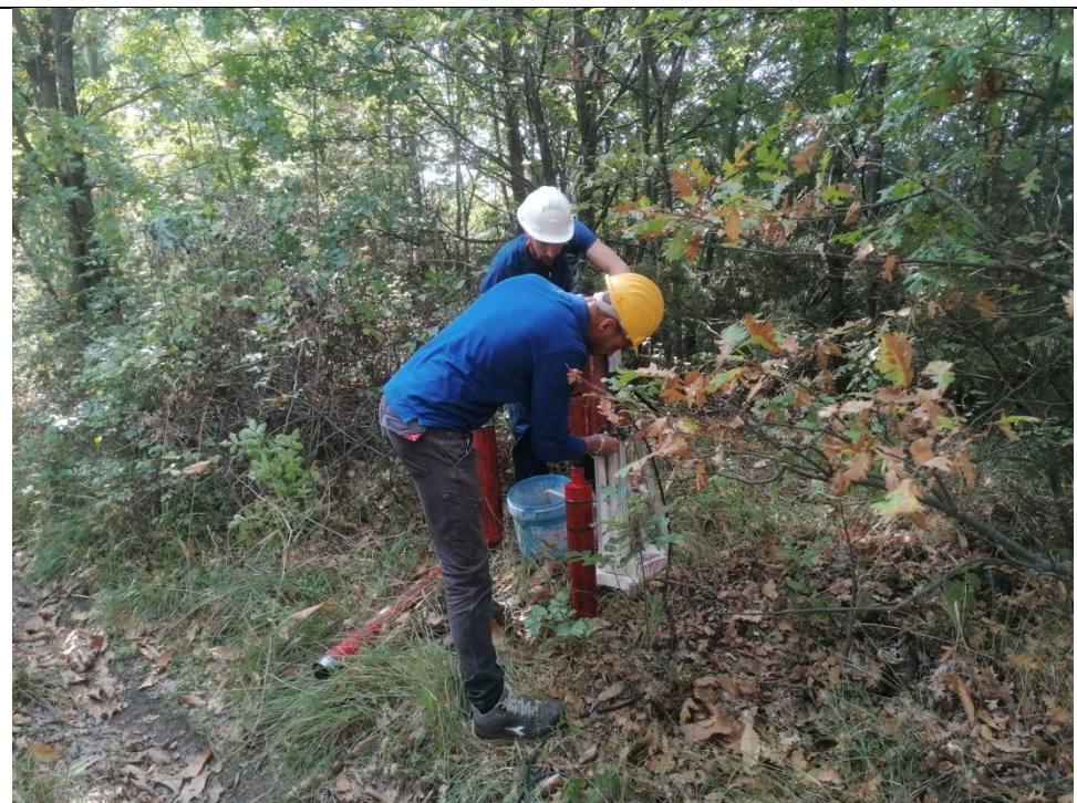
Esecuzione carotaggio P. 167
