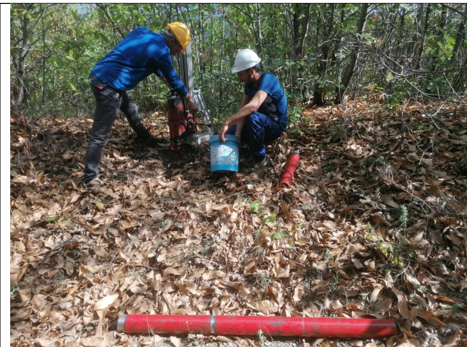
Esecuzione carotaggio P. 168
