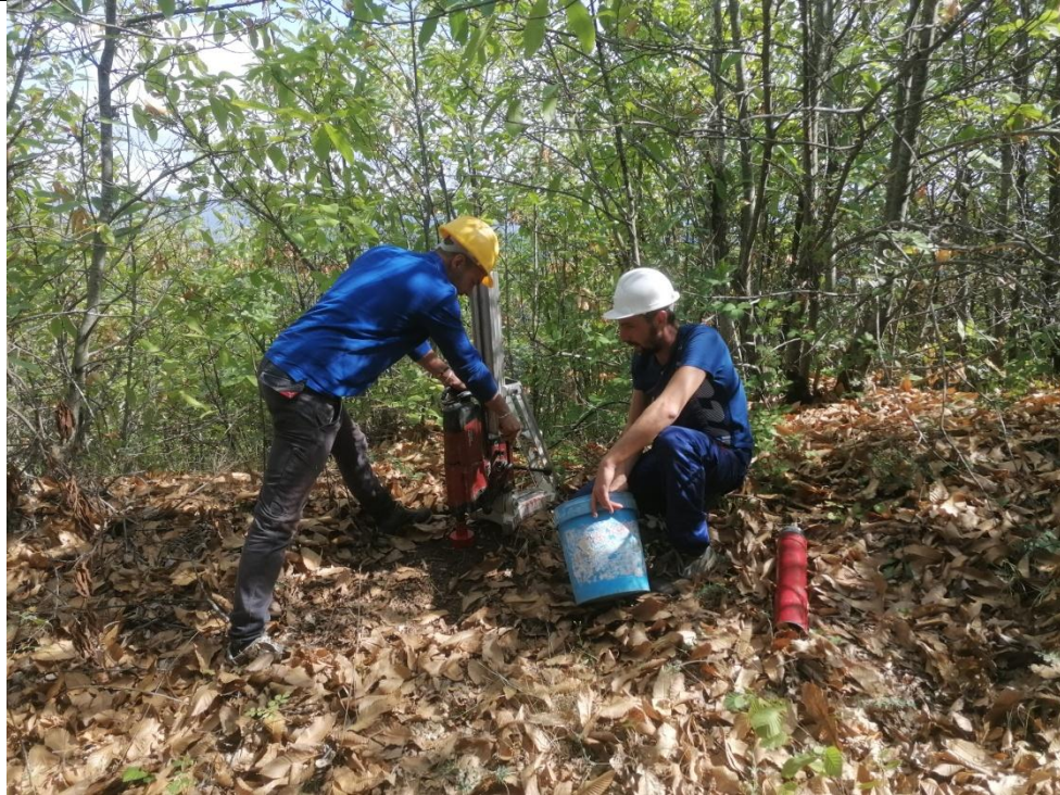
Esecuzione carotaggio P. 168
