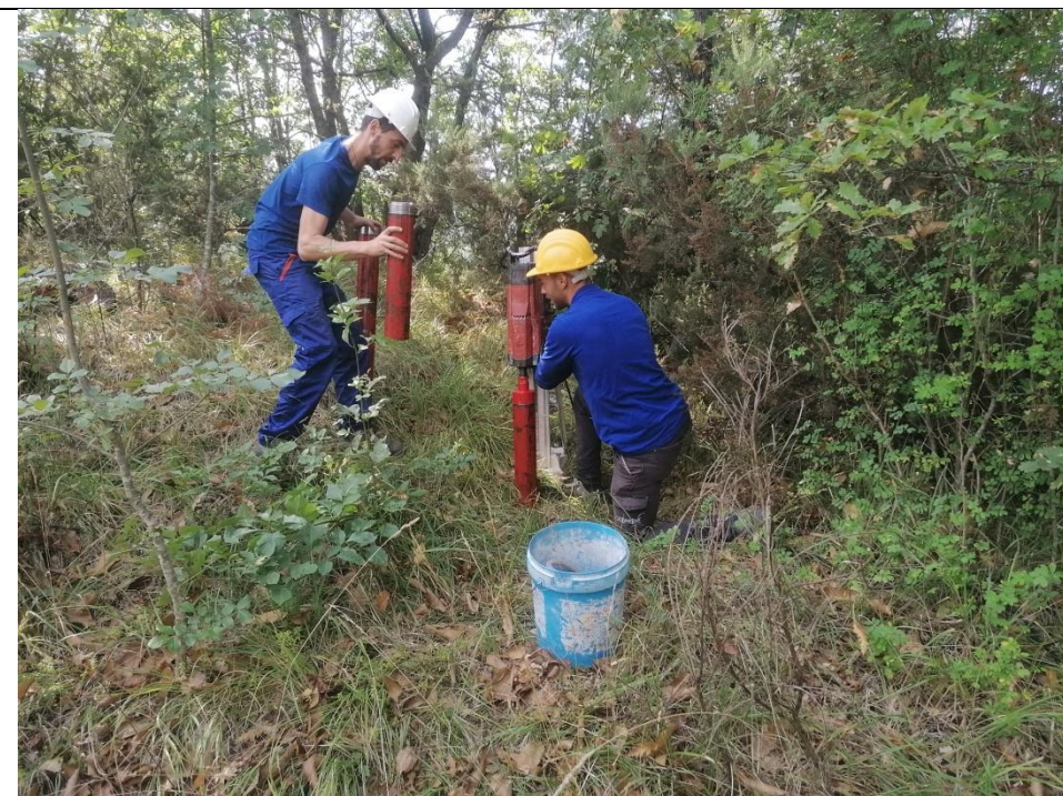
Esecuzione carotaggio P. 169
