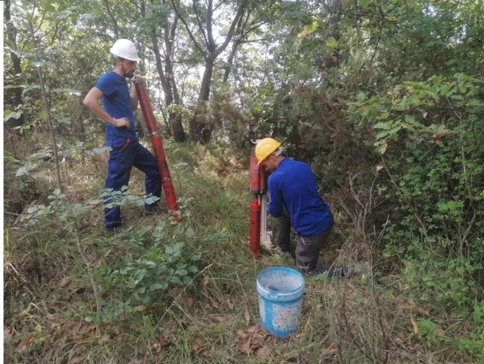
Esecuzione carotaggio P. 169
