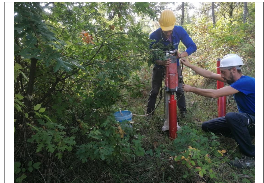
Esecuzione carotaggio P. 16G
