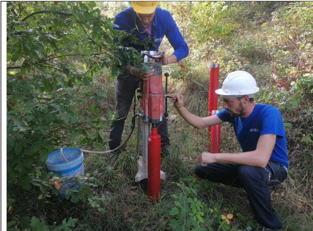
Esecuzione carotaggio P. 16G
