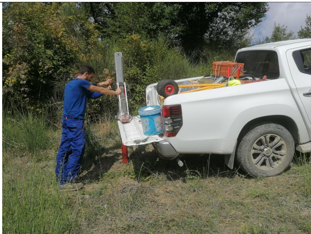
Esecuzione carotaggio P. 171
