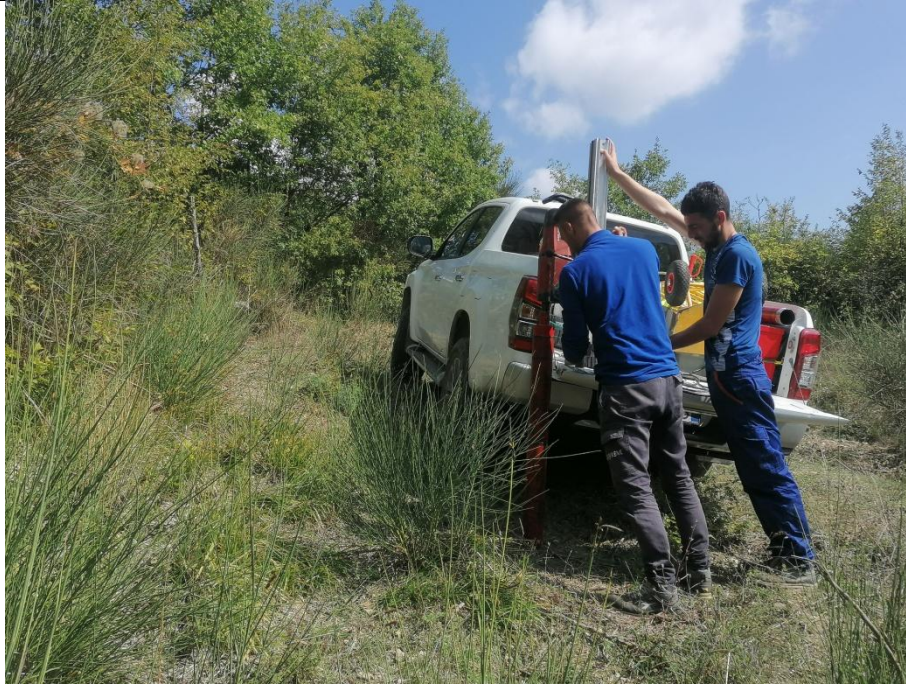
Esecuzione carotaggio P. 171
