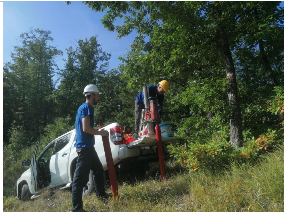
Esecuzione carotaggio P. 17G
