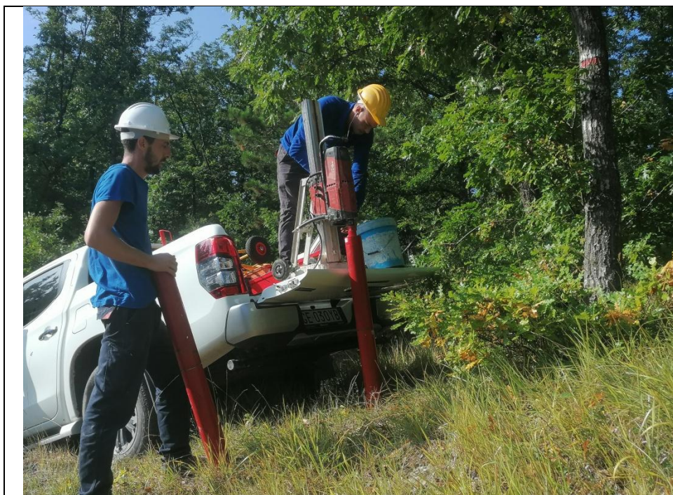
Esecuzione carotaggio P. 17G
