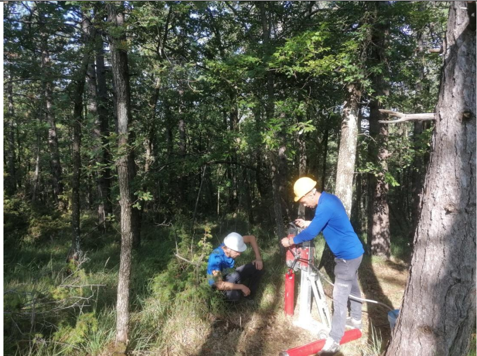
Esecuzione carotaggio P. 18G
