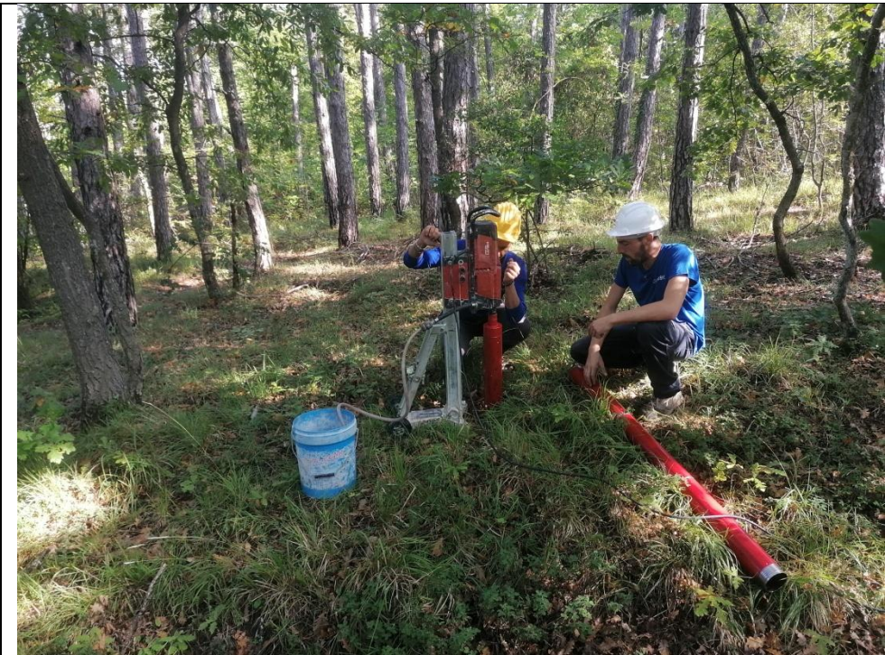
Esecuzione carotaggio P. 19G
