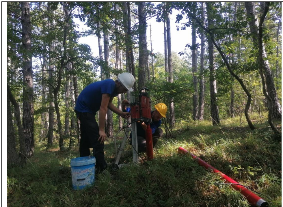
Esecuzione carotaggio P. 19G
