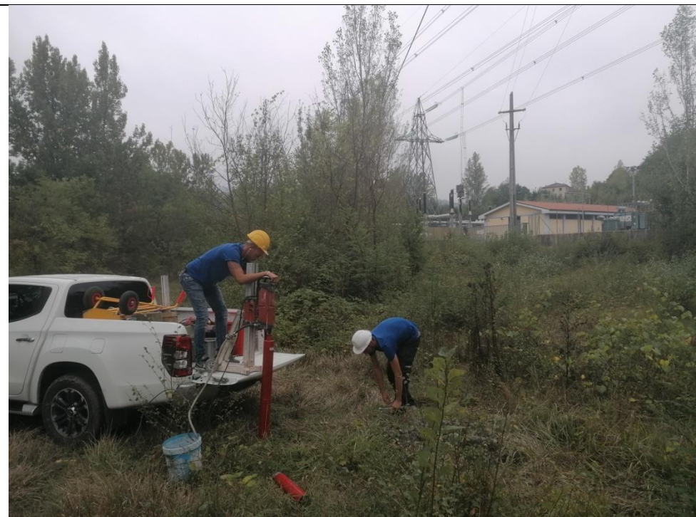
Esecuzione carotaggio P.1G
