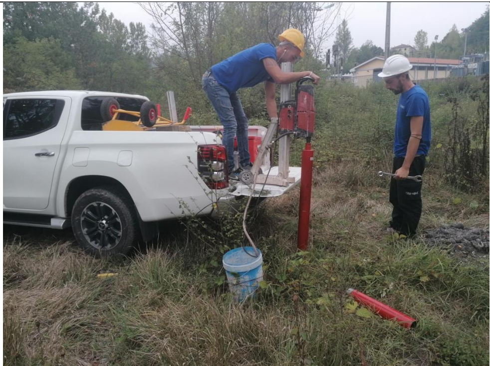
Esecuzione carotaggio P.1G
