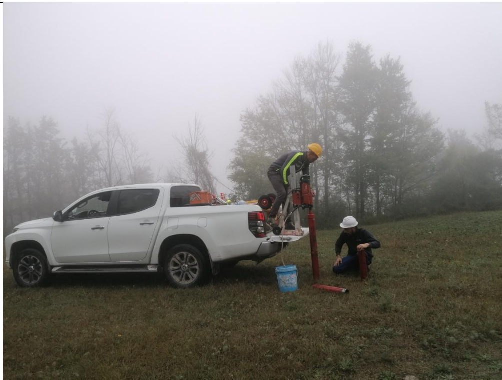
Esecuzione carotaggio P. 1H
