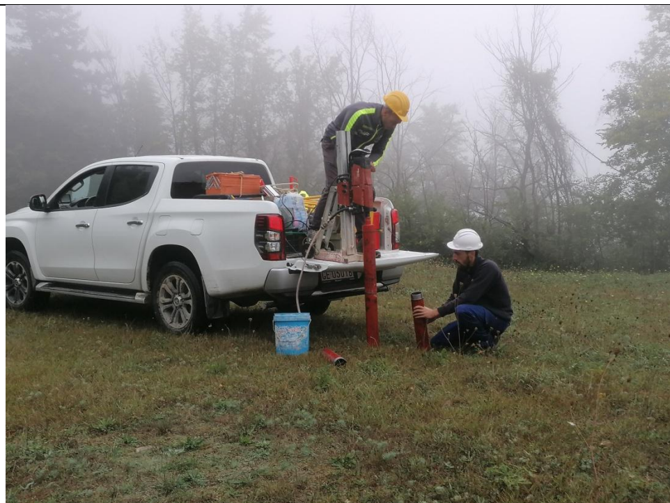
Esecuzione carotaggio P. 1H
