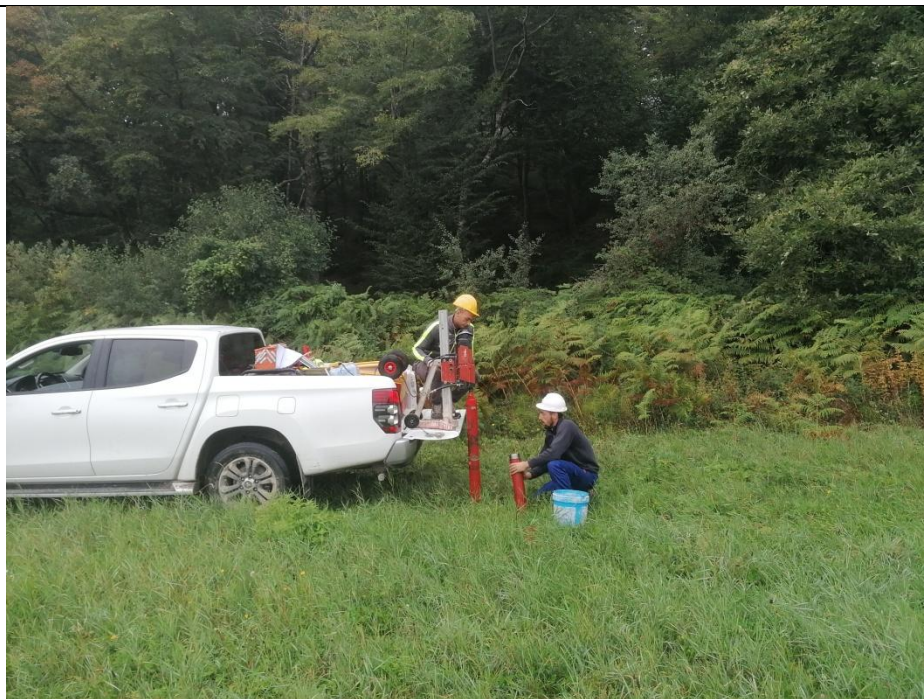
Esecuzione carotaggio P. 1J
