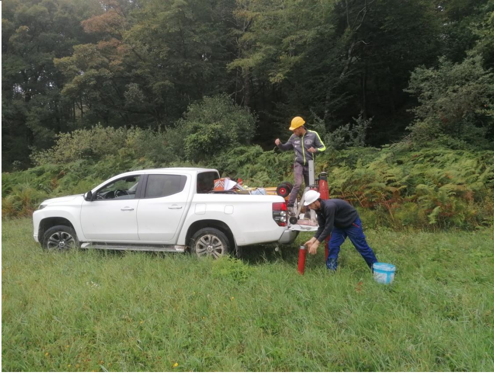
Esecuzione carotaggio P. 1J
