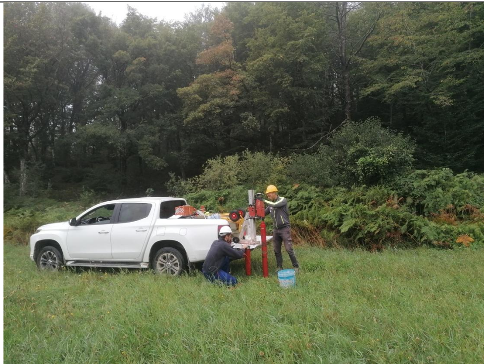
Esecuzione carotaggio P. 1K
