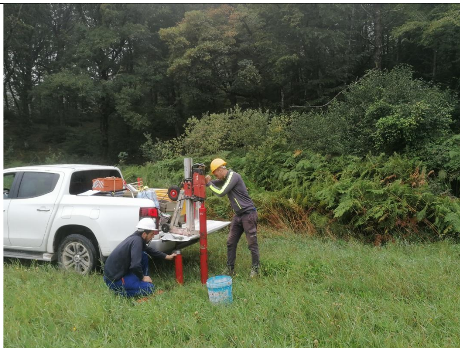
Esecuzione carotaggio P. 1K
