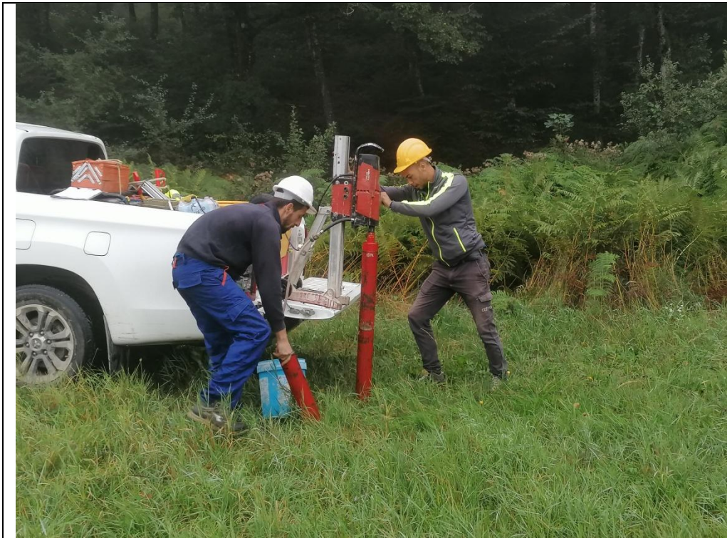
Esecuzione carotaggio P. 1L
