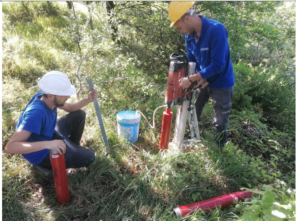
Esecuzione carotaggio P.21G
