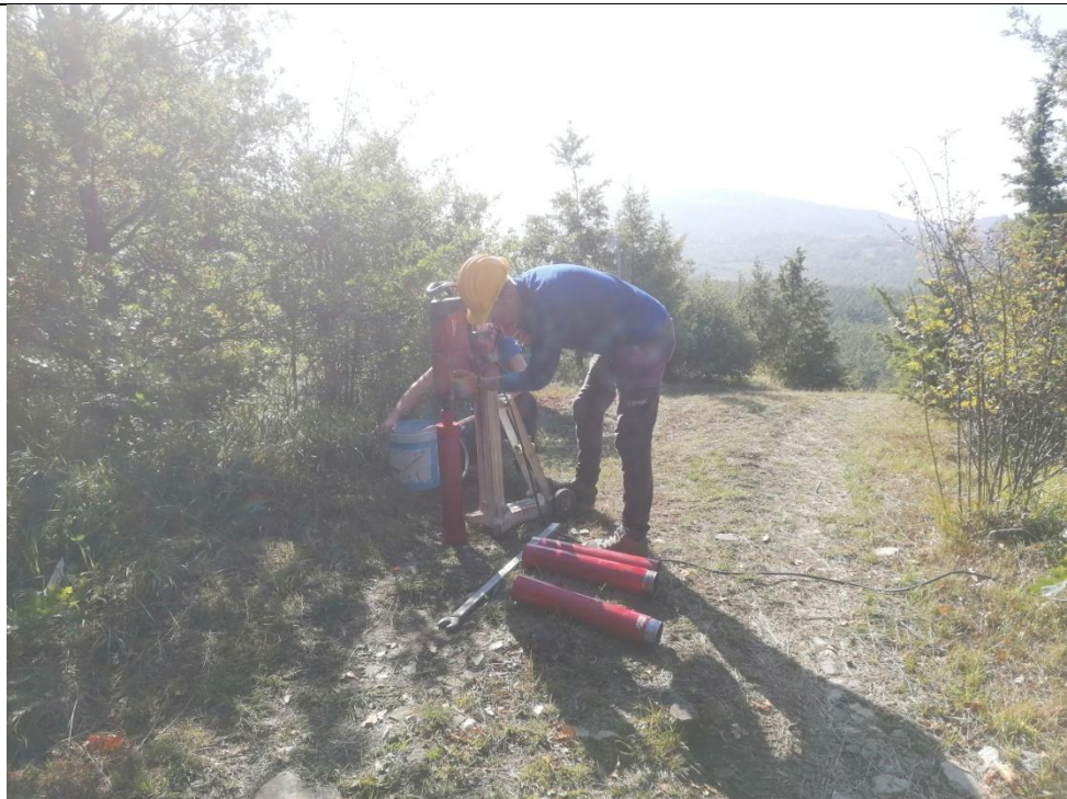
Esecuzione carotaggio P. 22G
