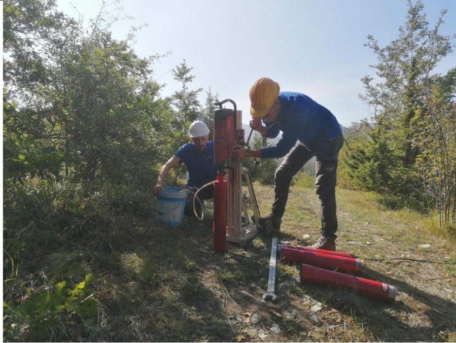
Esecuzione carotaggio P. 22G
