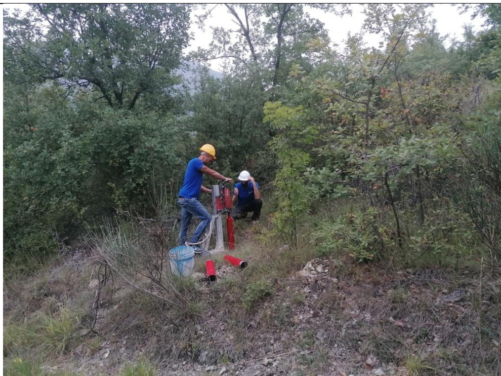
Esecuzione carotaggio P.2G
