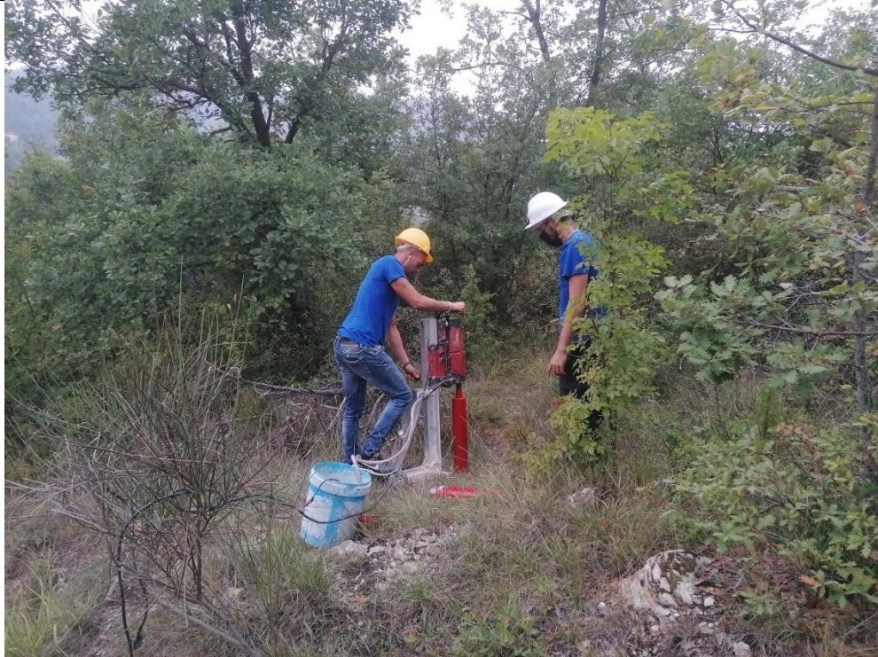
Esecuzione carotaggio P.2G
