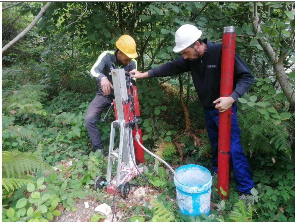
Esecuzione carotaggio P. 2K
