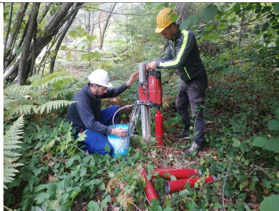
Esecuzione carotaggio P. 2L
