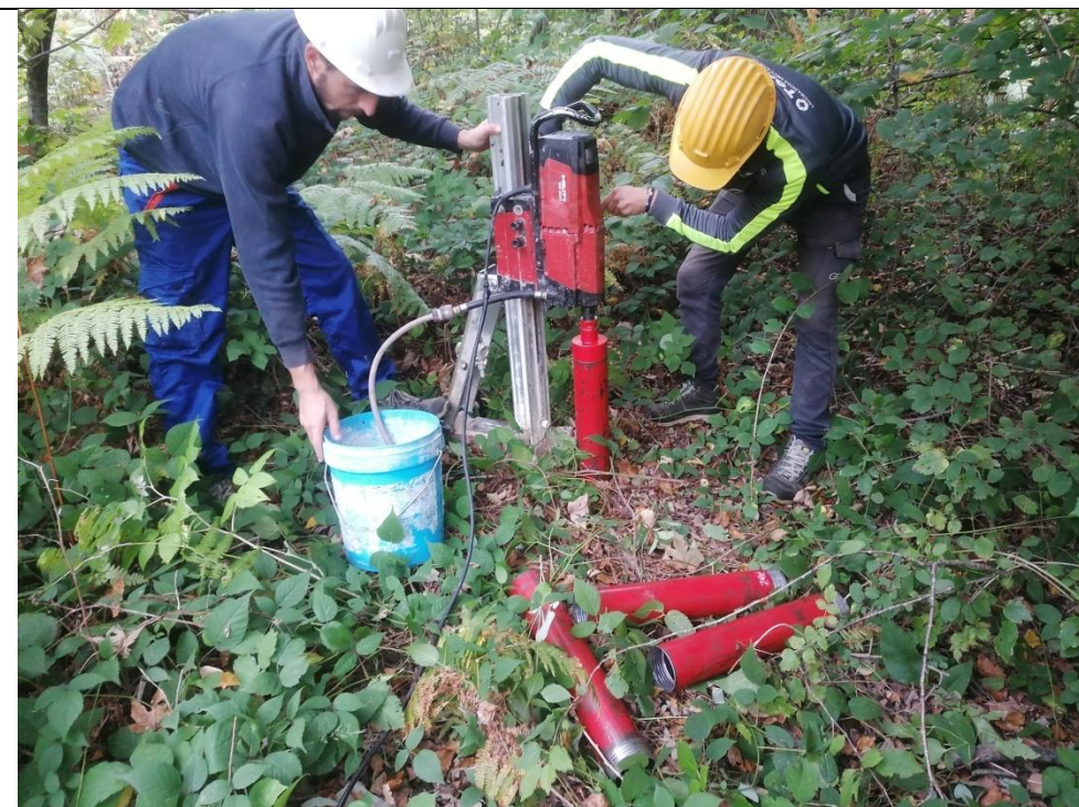
Esecuzione carotaggio P. 2L
