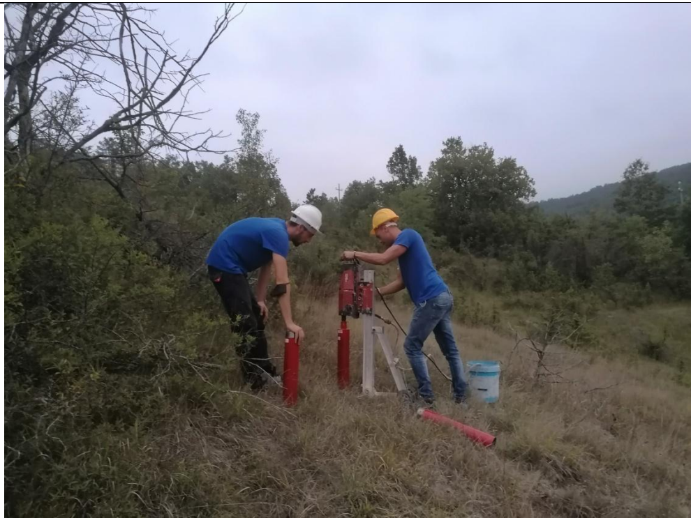
Esecuzione carotaggio P.3G
