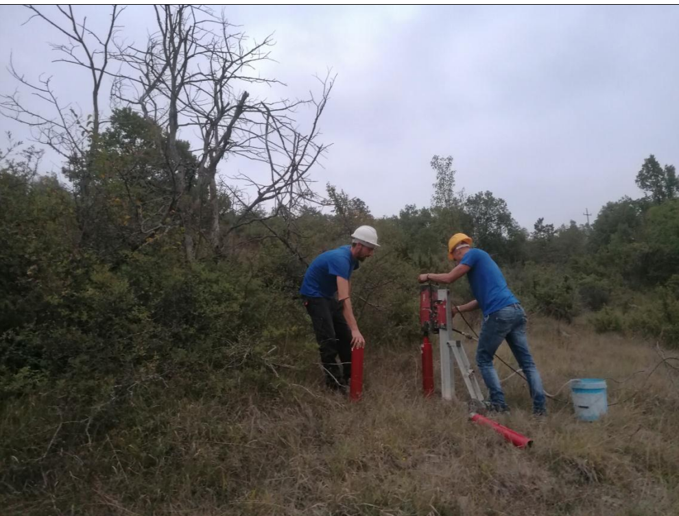
Esecuzione carotaggio P.3G
