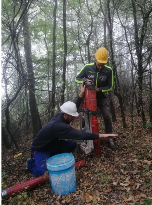
Esecuzione carotaggio P. 3H
