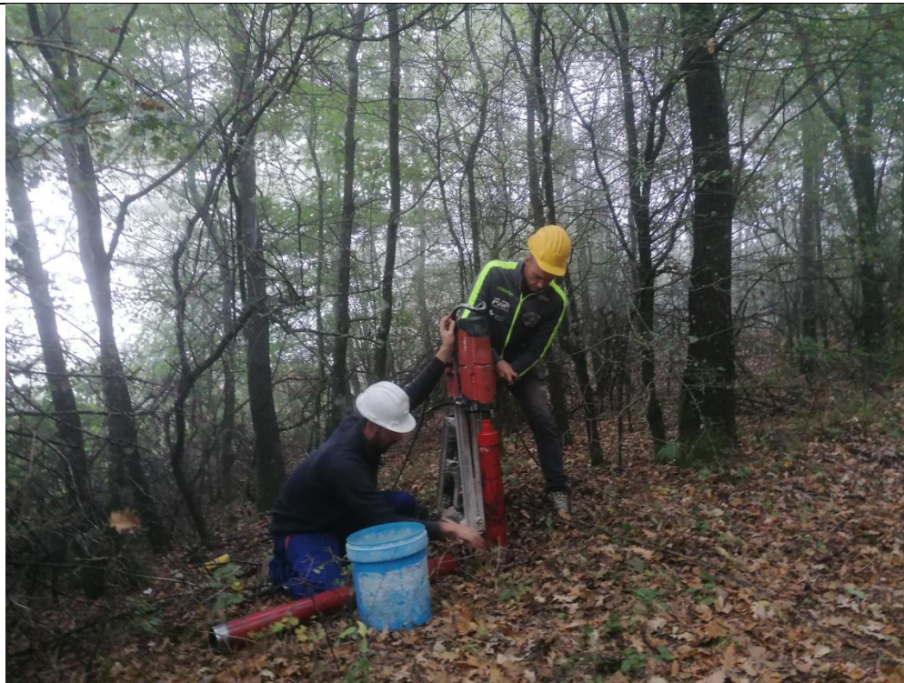
Esecuzione carotaggio P. 3H
