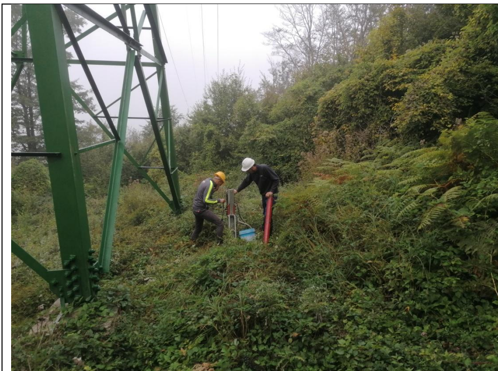
Esecuzione carotaggio P. 3K
