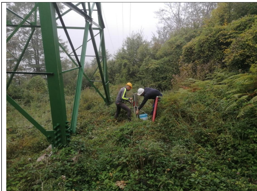
Esecuzione carotaggio P. 3K
