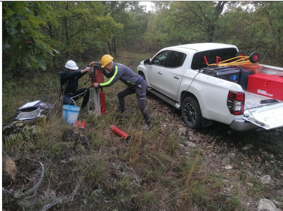
Esecuzione carotaggio P.4G
