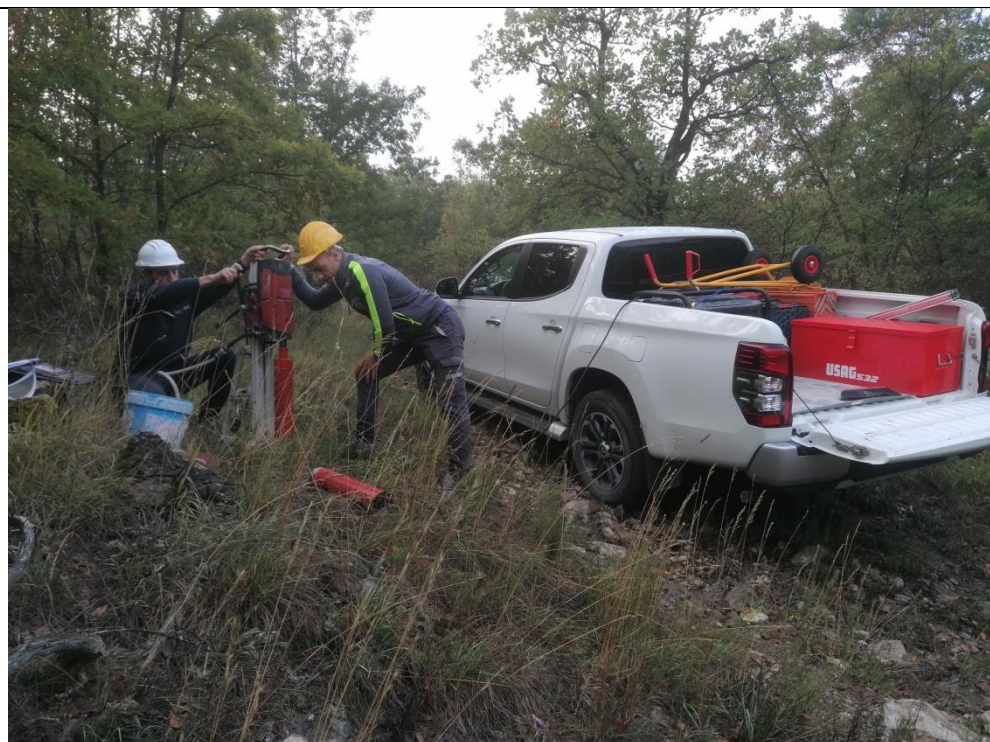
Esecuzione carotaggio P.3G
