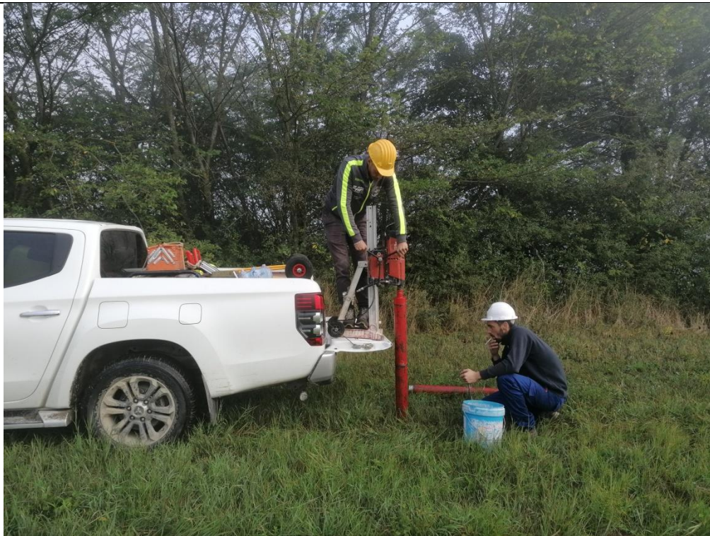
Esecuzione carotaggio P. 4H
