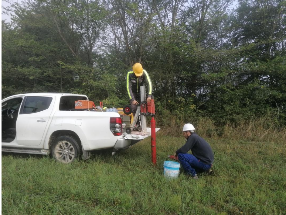
Esecuzione carotaggio P. 4H
