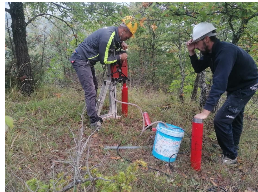
Esecuzione carotaggio P.5G
