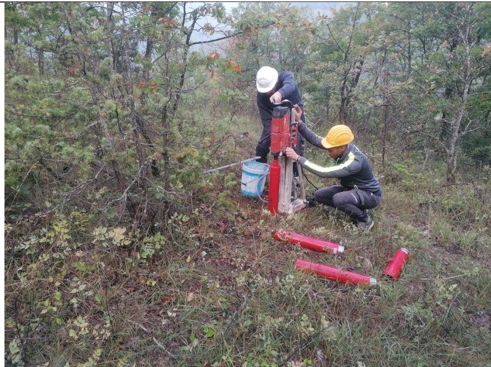
Esecuzione carotaggio P.5G
