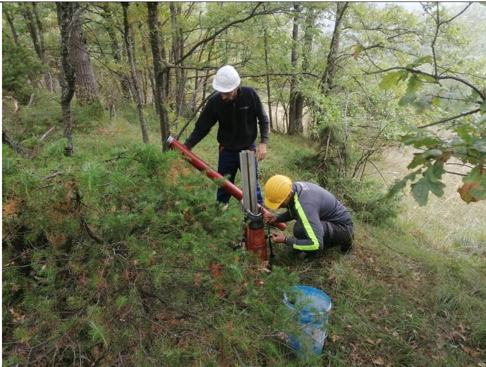
Esecuzione carotaggio P. 5H
