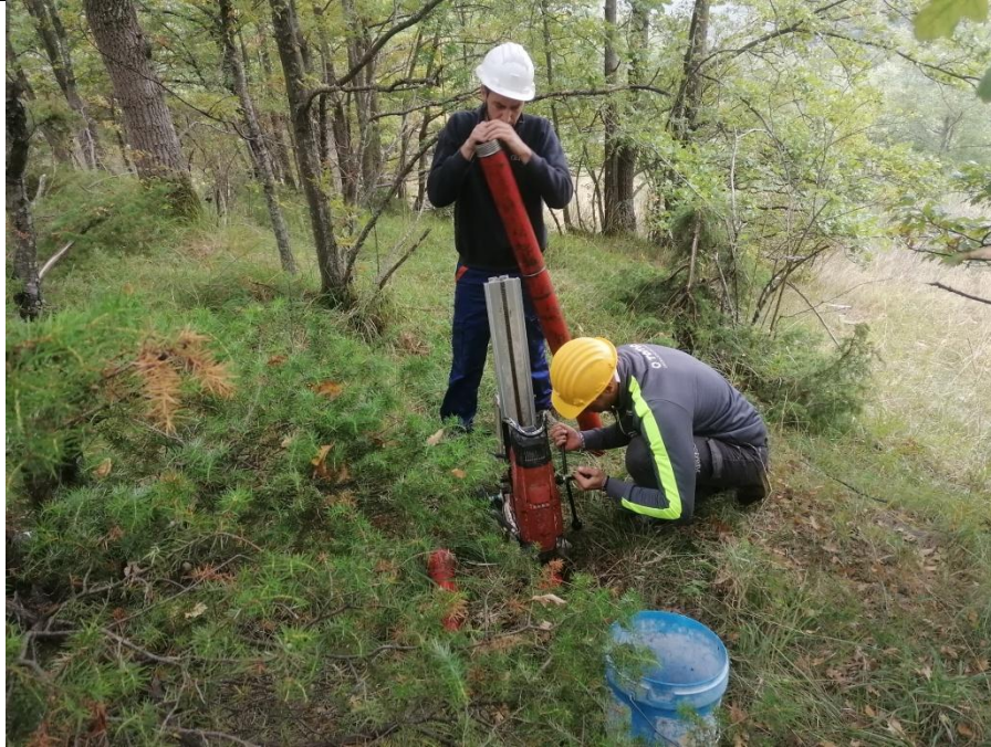
Esecuzione carotaggio P. 5H
